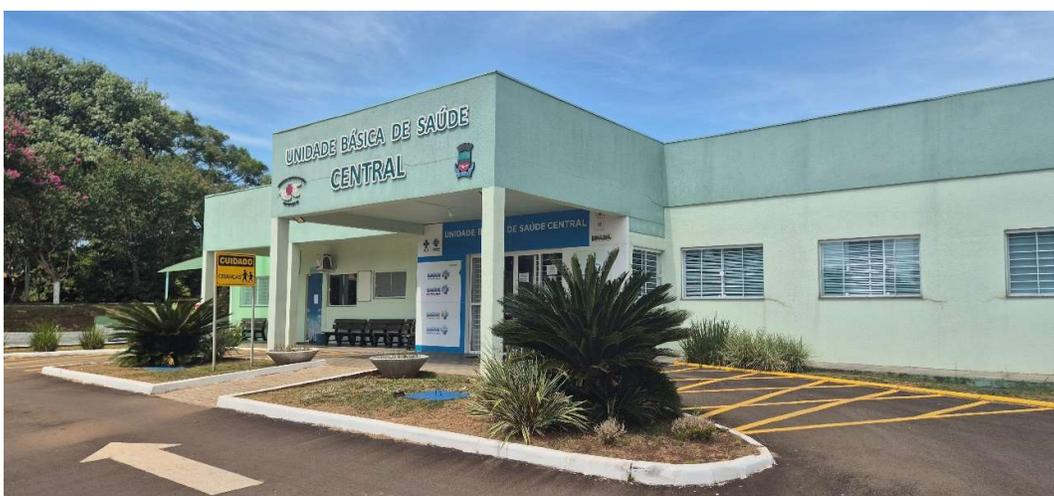
Fotos 1 e 2: Fachada Principal. Retirar letreiro e placas para corrigir fissuras e fazer a pintura.
