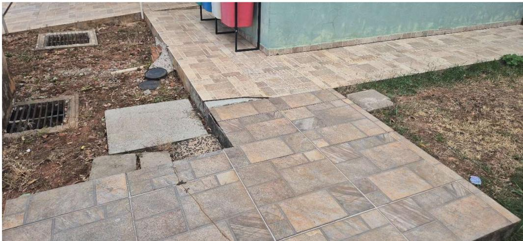
Foto 13: Substituir as peças cerâmicas quebradas e trincadas, fazer contrapiso e piso na parte frontal onde estão localizadas as caixas de drenagem
