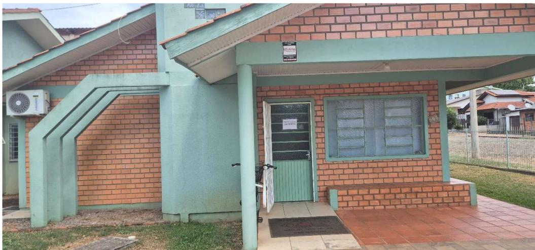
Fotos 1 e 2: Fachada Principal. Retirar letreiro e placas para corrigir fissuras e fazer a pintura das paredes e telhado.
