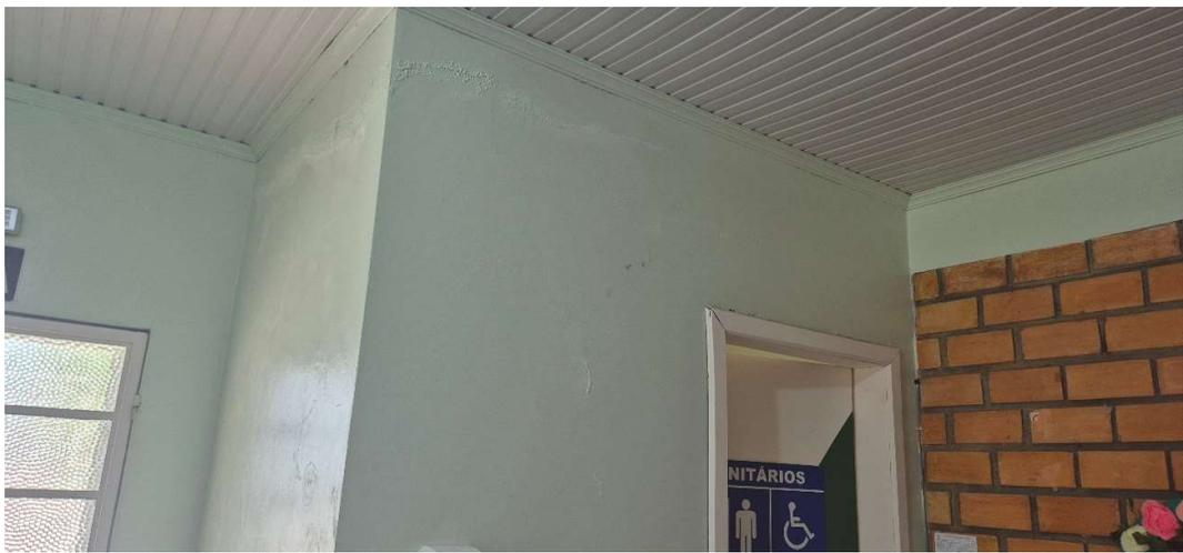
Fotos 9, 10, 11 e 12 : Arrumar patologias da superfície – retirar reboco, e refazer. Aplicar massa corrida e posteriormente as pinturas.
