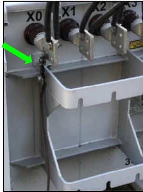
Fig. 3 – Aterramento do Neutro (X0)
