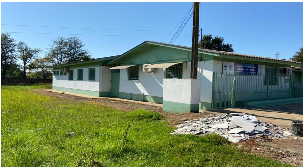
Fotos 6 e 7: Cobertura frontal existente de fibrocimento a ser substituída por aluzinco.
