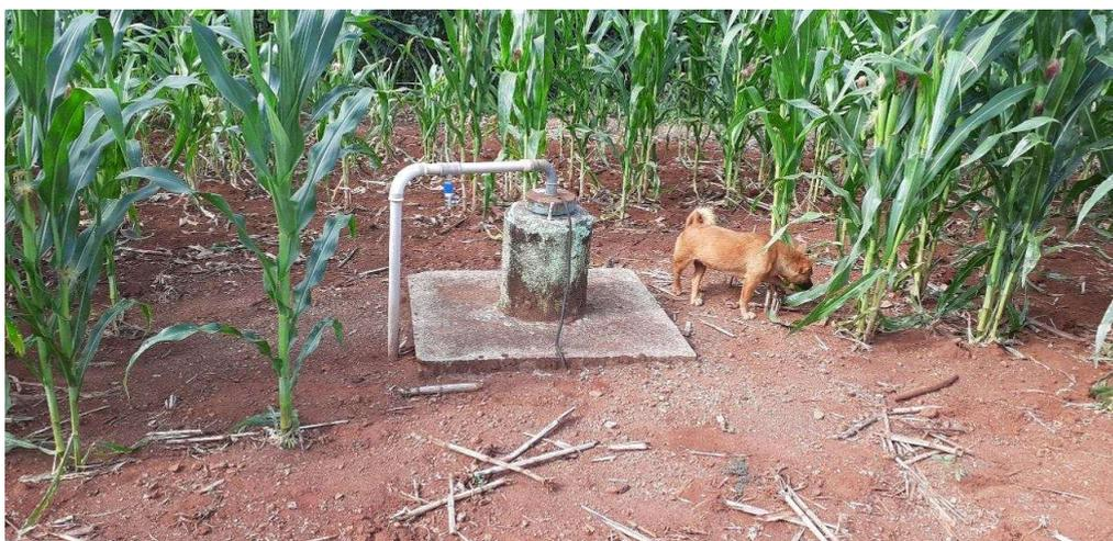
Fotos 1 e 2: Poço em funcionamento, mas sem infraestrutura adequada. Possui laje sanitária e tubulação de monitoramento. Faltam hidrômetro, torneira, dosador de cloro e cerca de proteção.
