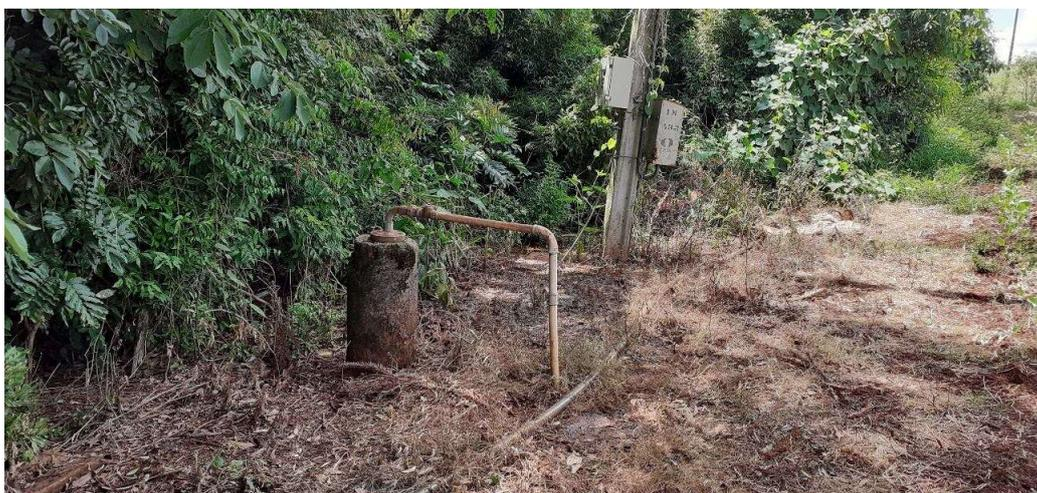
Fotos 3 e 4: Poço em funcionamento, mas sem infraestrutura adequada. Tem tubulação de monitoramento. Faltam laje sanitária, hidrômetro, torneira, dosador de cloro e cerca de proteção.
