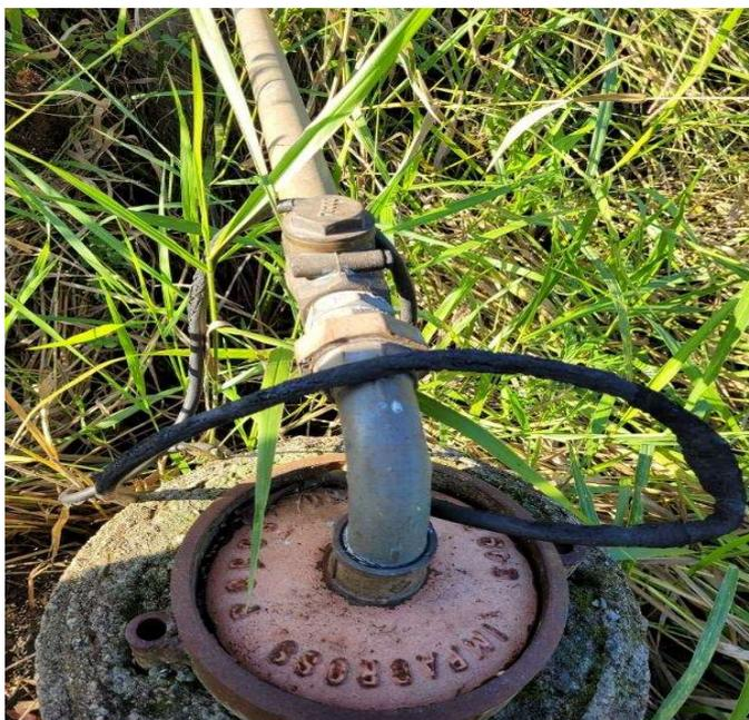
Fotos 15 e 16: Poço em funcionamento, mas sem infraestrutura adequada. Faltam adequar laje sanitária, hidrômetro, torneira, dosador de cloro e cerca de proteção.
