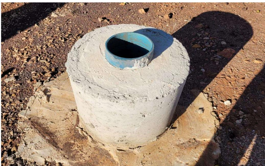
Fotos 25 e 26: Poço sem uso atualmente, sem infraestrutura adequada. Faltam tubulação de monitoramento com torneira, adequar laje sanitária, hidrômetro, dosador de cloro e cerca de proteção.
