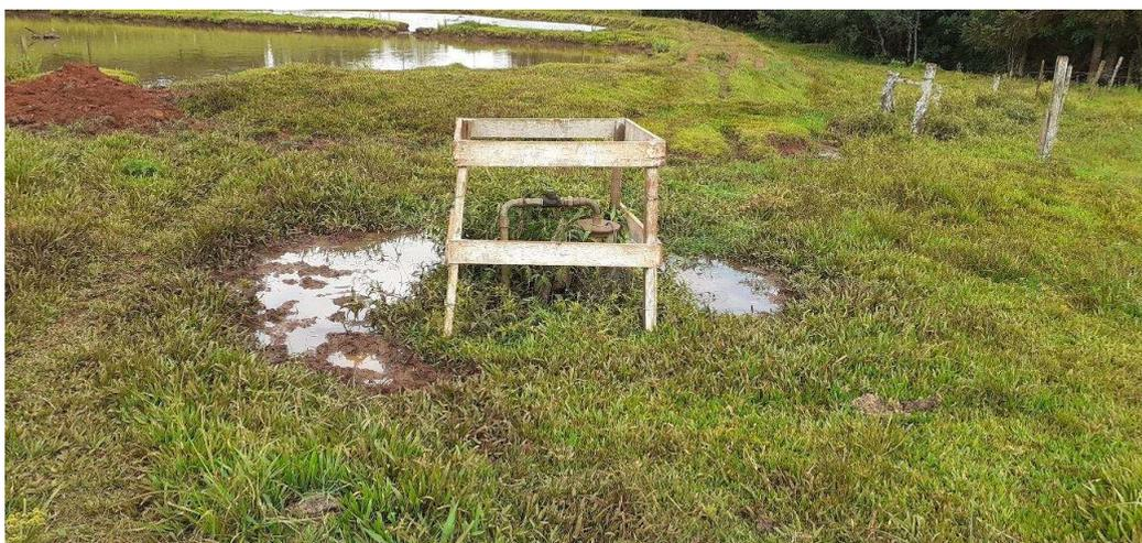
Fotos 9 e 10: Poço em funcionamento, mas sem infraestrutura adequada. Faltam laje sanitária, hidrômetro, torneira, dosador de cloro e cerca de proteção.
