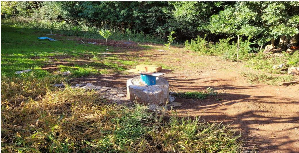
Fotos 27 e 28: Poço sem uso atualmente, sem infraestrutura adequada. Faltam tubulação de monitoramento com torneira, laje sanitária, hidrômetro, dosador de cloro e cerca de proteção.
