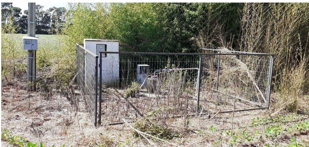
Fotos 7 e 8: Poço em funcionamento. Possui laje sanitária, hidrômetro, torneira, dosador de cloro e cerca de proteção. Falta torneira.
