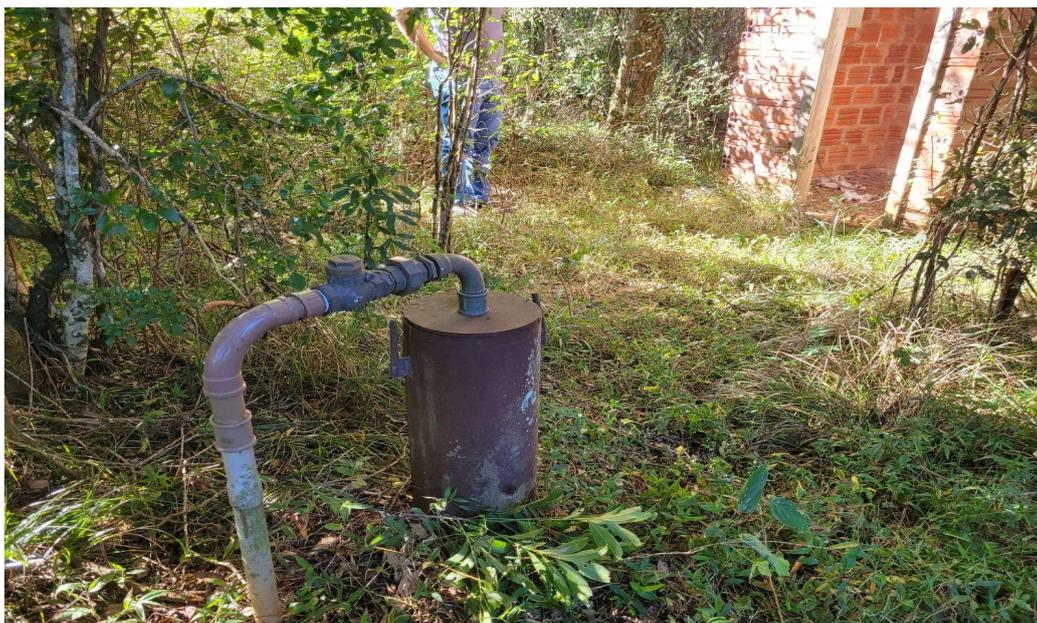
Fotos 21 e 22: Poço em funcionamento, mas sem infraestrutura adequada. Faltam laje sanitária, hidrômetro, torneira, dosador de cloro e cerca de proteção.
