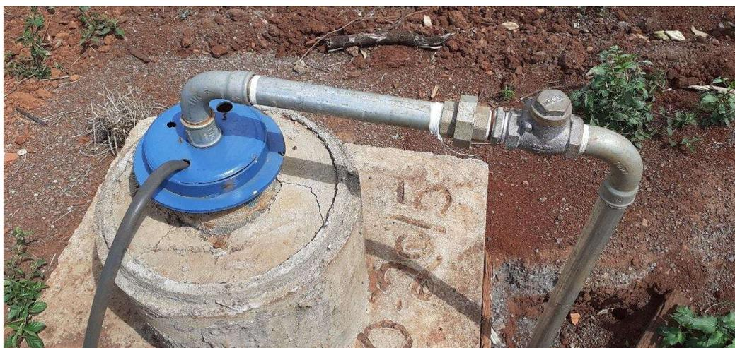
Fotos 5 e 6: Poço em funcionamento, mas sem infraestrutura adequada. Possui laje sanitária e tubulação de monitoramento. Faltam hidrômetro, torneira, dosador de cloro e cerca de proteção.
