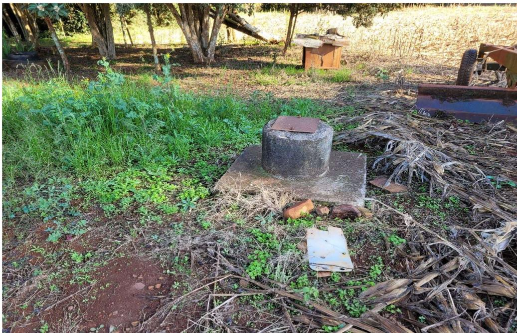
Fotos 13 e 14: Poço sem uso atualmente, sem infraestrutura adequada. Faltam tubulação de monitoramento com torneira, hidrômetro, torneira, dosador de cloro e cerca de proteção.
