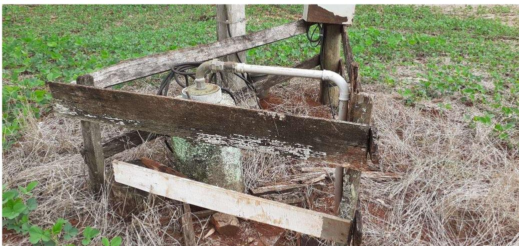
Fotos 23 e 24: Poço em funcionamento, mas sem infraestrutura adequada. Faltam laje sanitária, hidrômetro, torneira, dosador de cloro e cerca de proteção.
