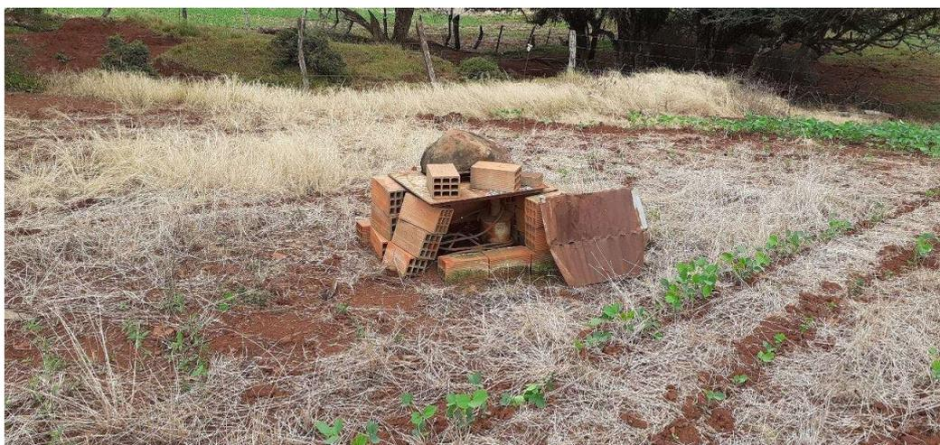
Fotos 17 e 18: Poço em funcionamento, mas sem infraestrutura adequada. Faltam laje sanitária, hidrômetro, torneira, dosador de cloro e cerca de proteção.
