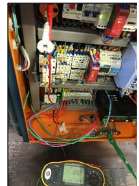
Loop de Impedância (QD → Equip.)
