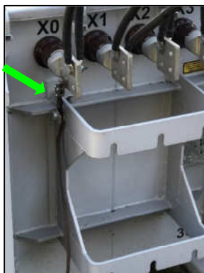
Fig. 3 – Aterramento do Neutro (X0)
