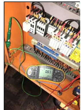
Loop de Impedância (QD → Equip.)
