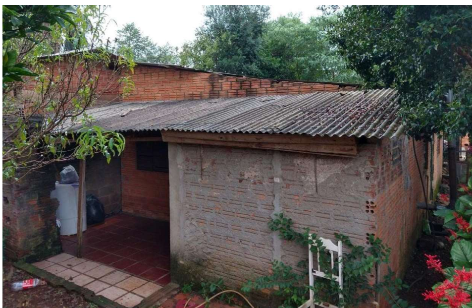
Edificação, conforme vistoria em 17 de abril de 2023.
