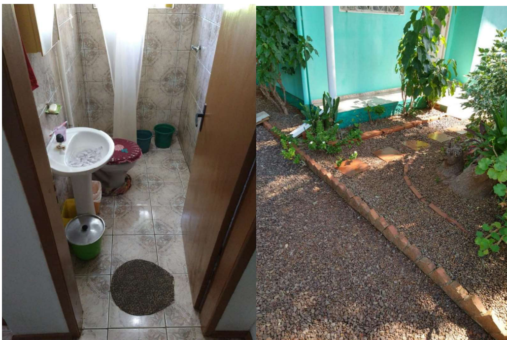
Edificação, conforme vistoria em 01 de março de 2022.
