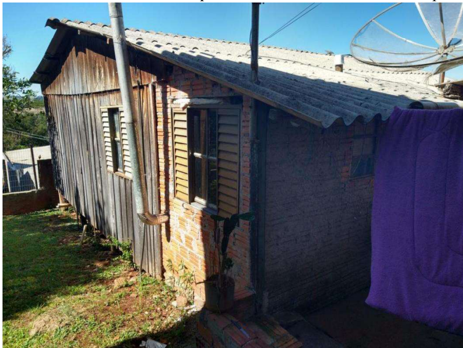
Edificação, conforme vistoria em 28 de abril de 2023.
