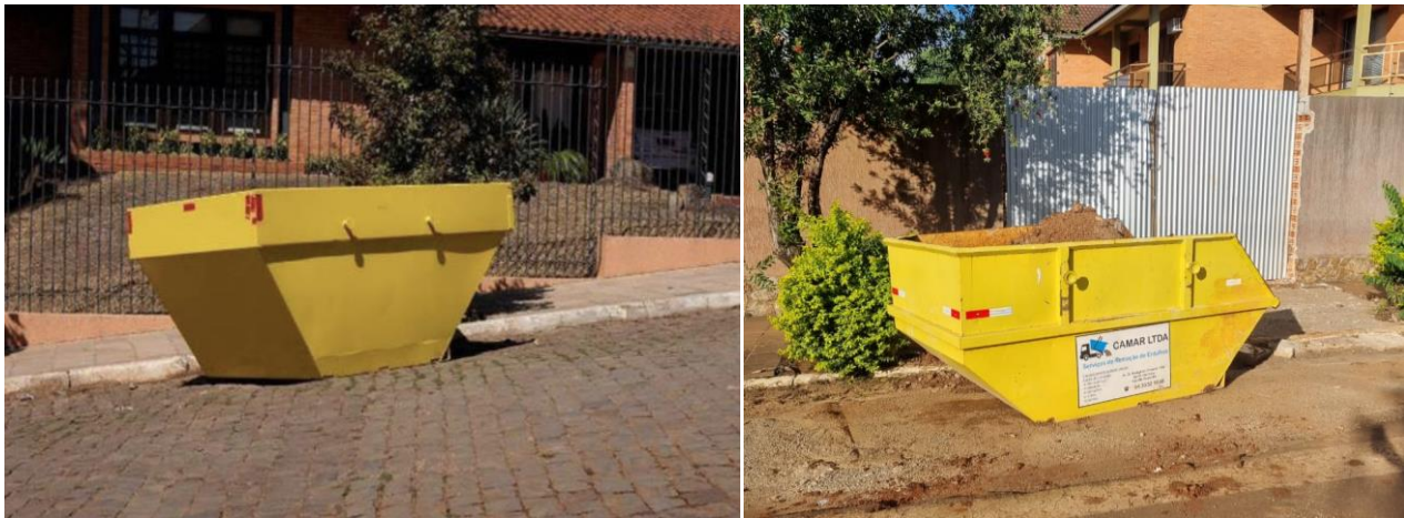
Figura 37. Coletores terceirizados de resíduos de construção civil
