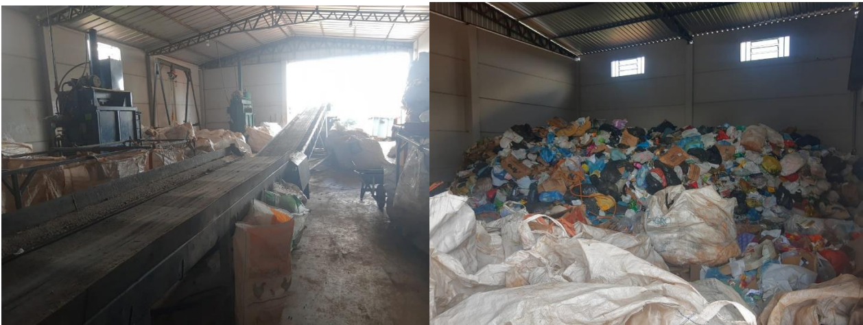
Figuras 23 e 24. Áreas internas (esteira de segregação e área de transbordo)
