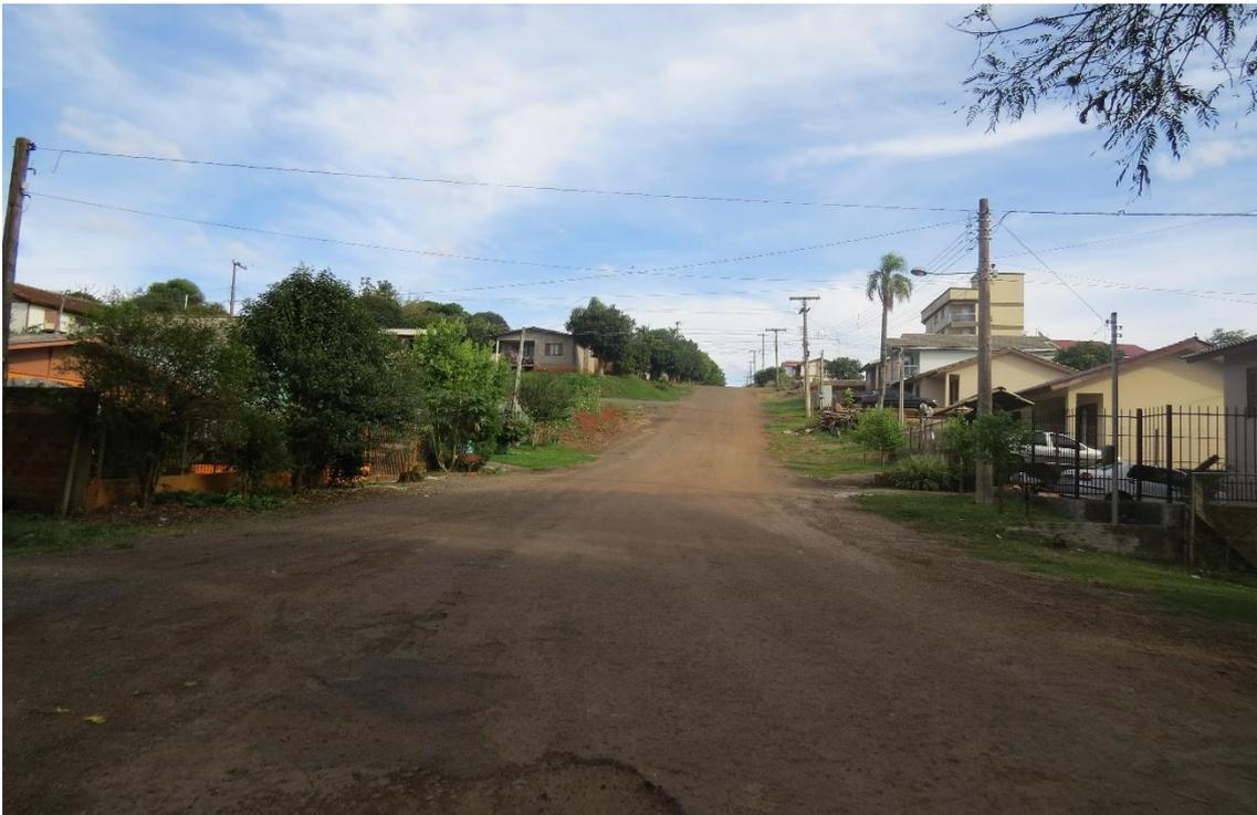
Foto 06: Rua Amazonas. Vista geral. Será executada pavimentação em CBUQ com espessura de 04 cm e base de 15 cm. Meio fio em concreto pré-moldado. Existe revestimento de resíduo asfáltico.
