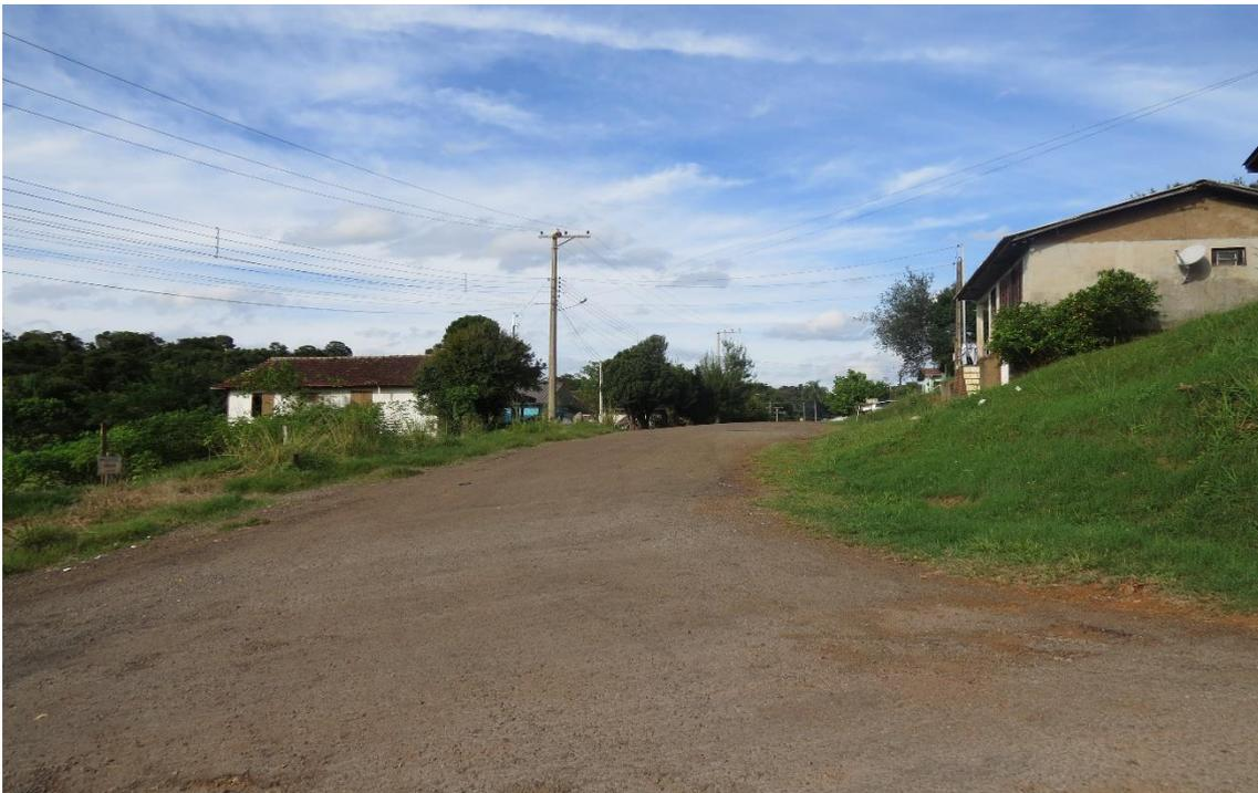
Foto 05: Rua Pará. Será executada pavimentação em CBUQ com espessura de 04 cm e base de 15 cm. Meio fio em concreto pré-moldado. Existe revestimento de resíduo asfáltico.
