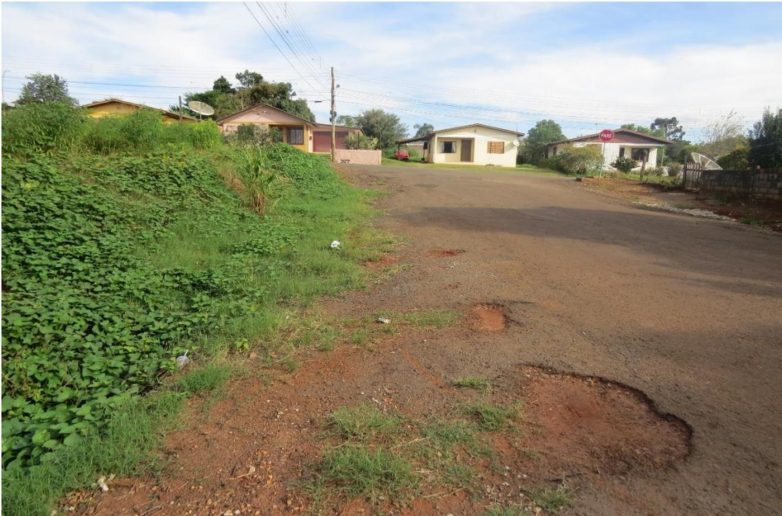
Foto 08: Rua Piauí. Será executada pavimentação em CBUQ com espessura de 04 cm e base de 15 cm. Meio fio em concreto pré-moldado. Existe revestimento de resíduo asfáltico.
