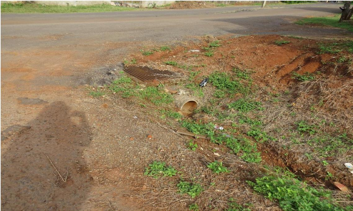
Foto 04: Entroncamento da Avenida Brasília com a Rua Pará. Será executada microdrenagem e feito adequação das bocas de lobo existentes.
