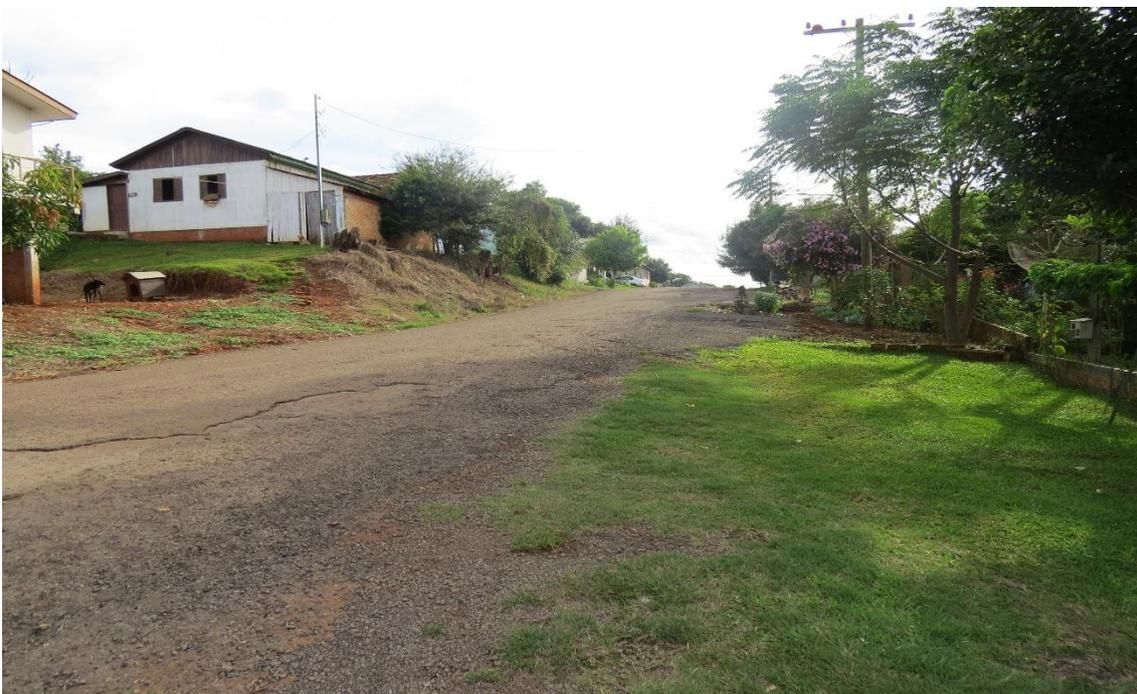
Foto 03: Rua Pará. Será executada pavimentação em CBUQ com espessura de 04 cm e base de 15 cm. Meio fio em concreto pré-moldado. Existe revestimento de resíduo asfáltico.
