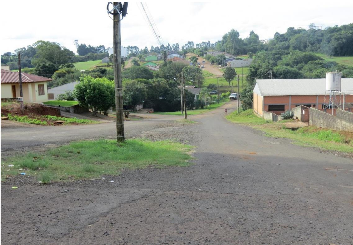
Foto 01: Avenida Brasília. Microdrenagem existente de um lado da rua. Será executada pavimentação em CBUQ com espessura de 04 cm e base de 15 cm. Será feito canteiro central com plantio de grama. Meio-fio será em concreto pré-moldado. Existe revestimento de resíduo asfáltico.
