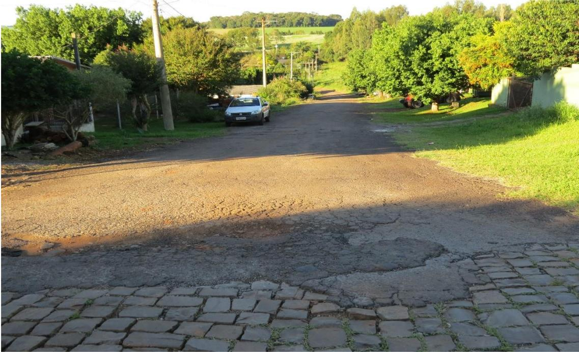
Foto 10: Rua Centenário. Será executada pavimentação em CBUQ com espessura de 04 cm e base de 15 cm. Meio fio em concreto pré-moldado. Existe revestimento de resíduo asfáltico.
