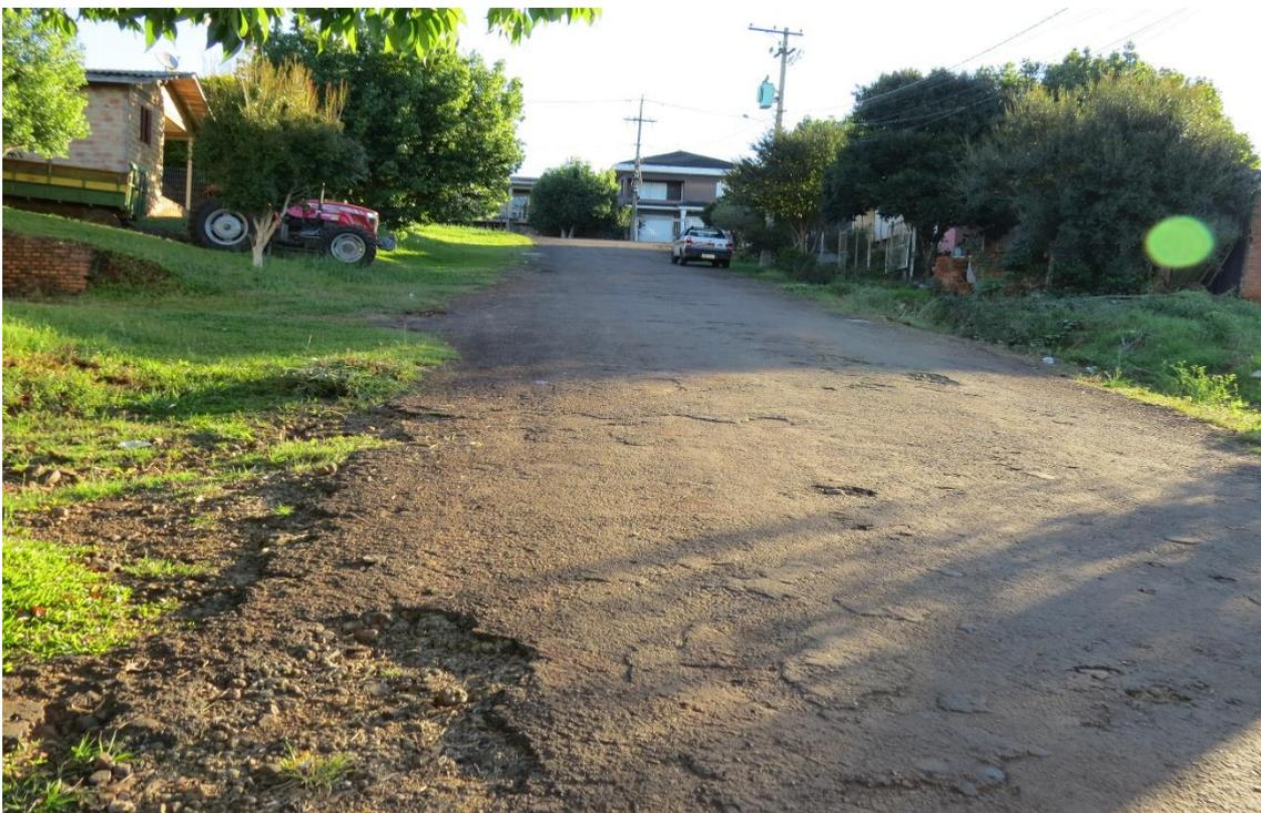
Foto 11: Rua Centenário. Vista geral. Será executada pavimentação em CBUQ com espessura de 04 cm e base de 15 cm. Meio fio em concreto pré-moldado. Existe revestimento de resíduo asfáltico.
