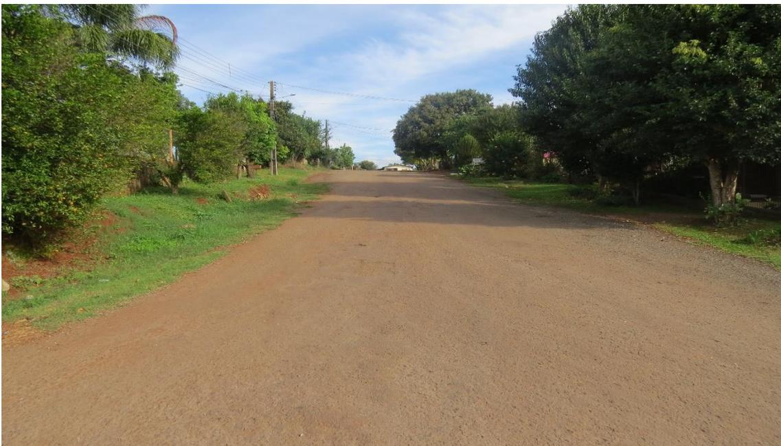
Foto 09: Rua Piauí. Vista geral. Será executada pavimentação em CBUQ com espessura de 04 cm e base de 15 cm. Meio fio em concreto pré-moldado. Existe revestimento de resíduo asfáltico.
