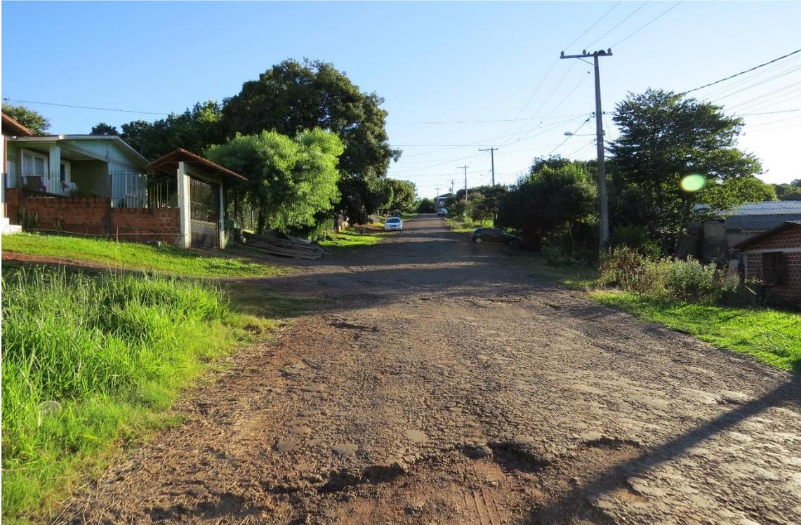
Foto 12: Rua Centenário. Vista geral. Será executada pavimentação em CBUQ com espessura de 04 cm e base de 15 cm. Meio fio em concreto pré-moldado. Existe revestimento de resíduo asfáltico.
