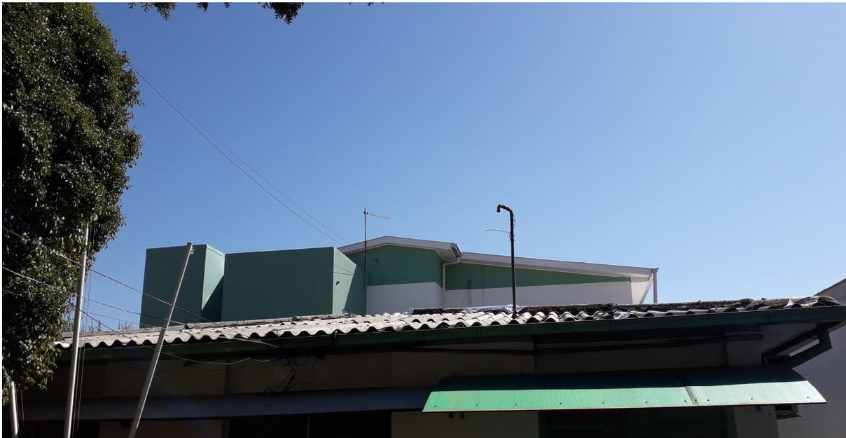
Foto 07. Retirar e reaproveitar calha. Fazer um corte retangular na parte superior da calha. Substituir o condutor existente por Ø 100 mm
