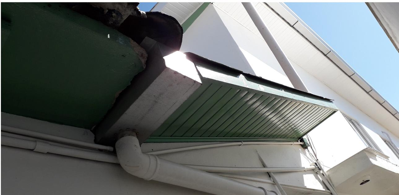
Foto 08. Retirar e reaproveitar calhas . Substituir a calha menor.
