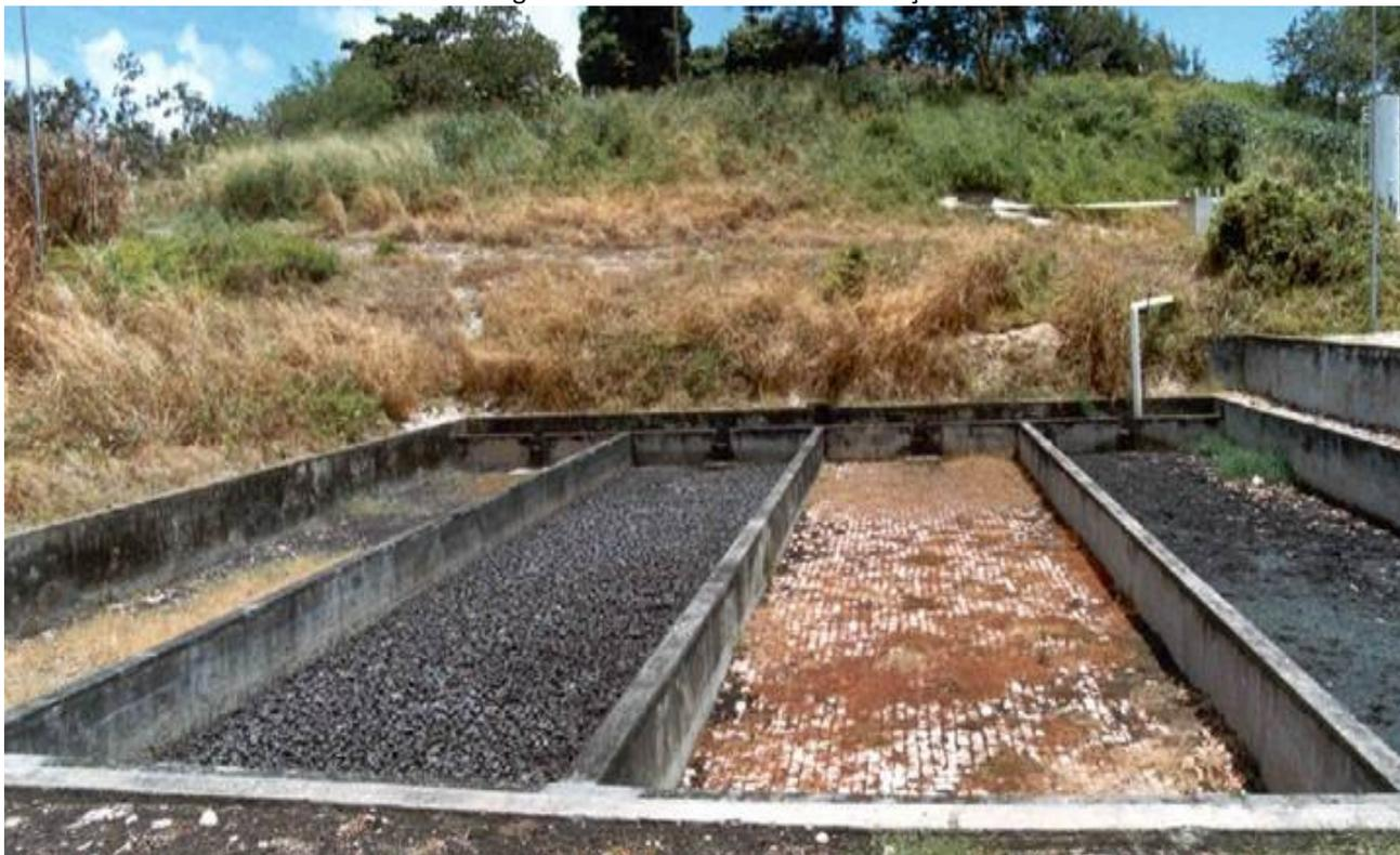
A Figura 18 ilustra um corte de um leito de secagem.
